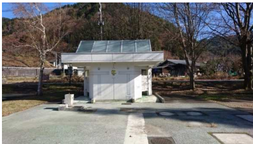
【坂巻公園】老朽化したトイレの建て替え
