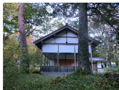
東屋の塗装補修
