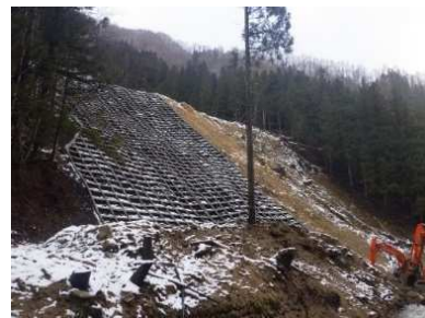
復旧工事が進む小谷川（宮川町）
