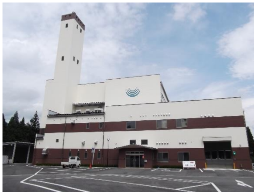
▲飛騨市クリーンセンター（古川町）
