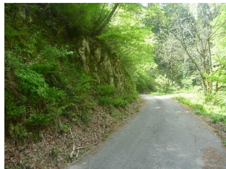
▲崩落の恐れがある法面 (安峰線)
