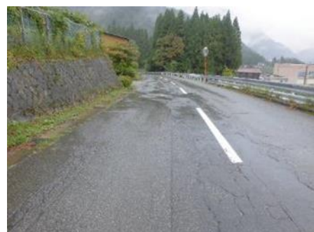
▲劣化した舗装の補修
