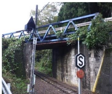
▲杉原～小豆沢線（JR跨線橋の架替）
