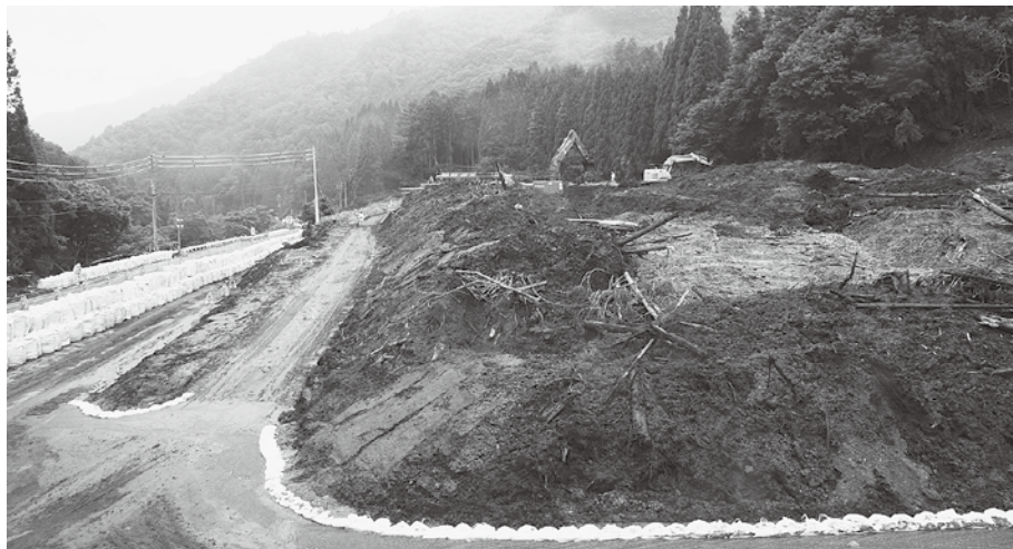
国道41号 約100mに渡り 土砂流出（古川町数河地内）
