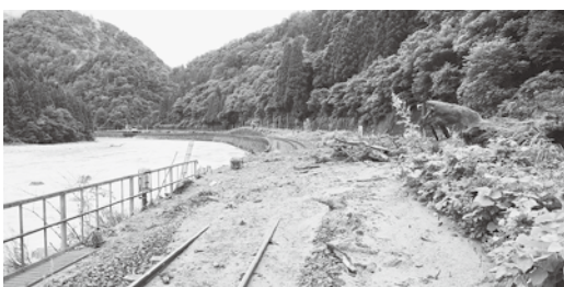
宮川町内での土砂災害 (H30.7)
