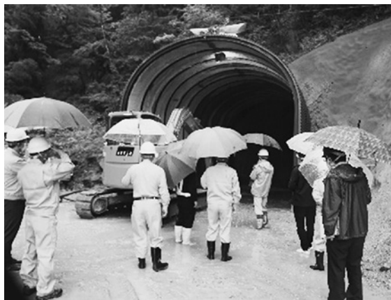
⑤ HK工事現場
