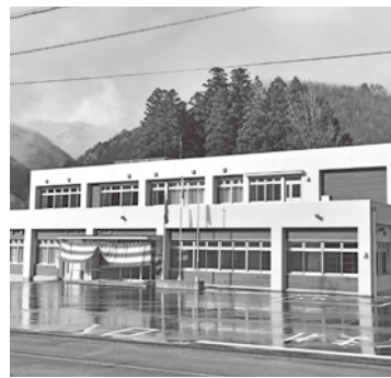
▲宮川振興事務所・宮川町公民館
