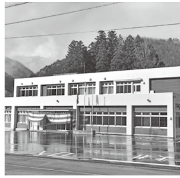
▲宮川振興事務所・宮川町公民館
