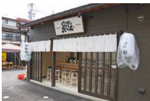
店舗外観の様子
