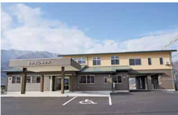
完成した施設の外観
