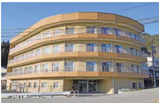
完成した施設の外観
