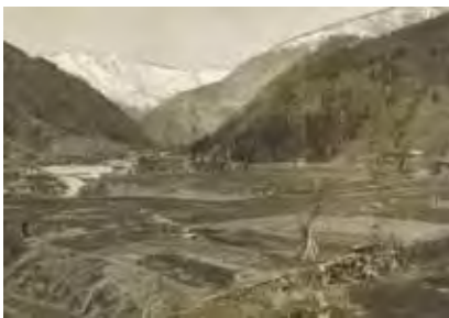
公園整備前の東町城跡のようす （写真：大坪洋子氏提供）
