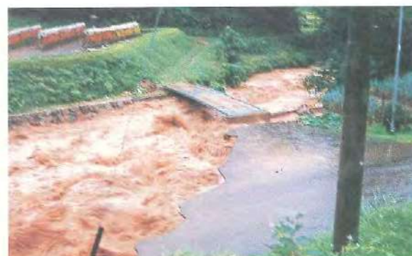
増水で徐々に削られる道
