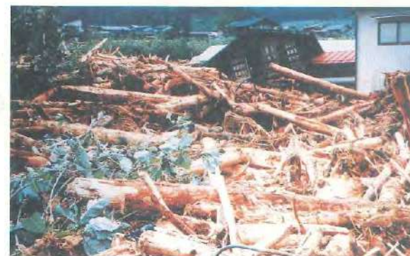
流木により押しつぶされた建物
