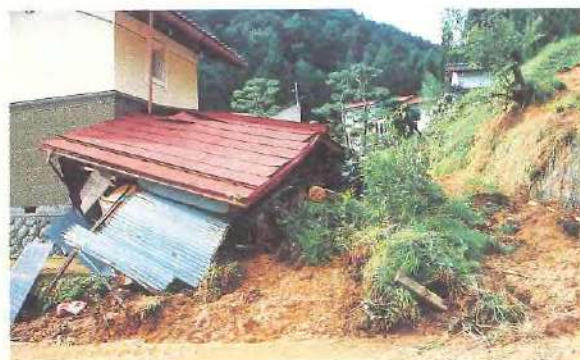
豪山が崩れ犠牲となられた現場
