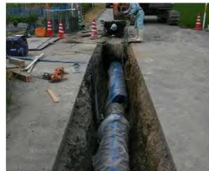
硬質塩化ビニル管を耐震性能の高い青ポリ管に随時敷設替えを進めています。
