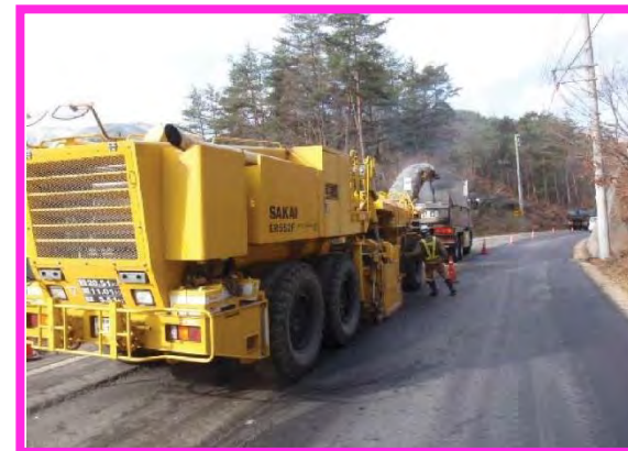
3-1.路面切削工 (大型切削機)
