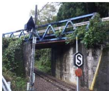
▲杉原～小豆沢線（JR跨線橋の架替）
