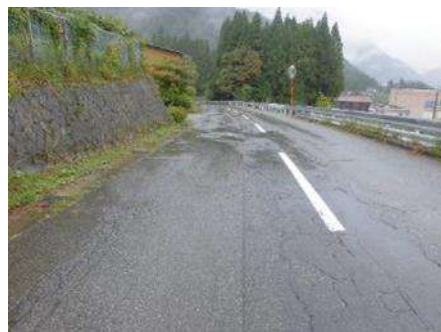
▲劣化した舗装の補修
