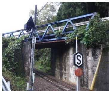
▲杉原～小豆沢線（JR跨線橋の架替）
