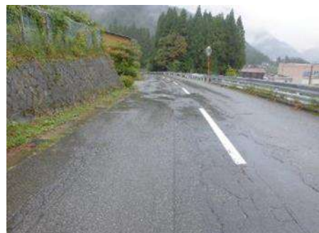
▲劣化した舗装の補修
