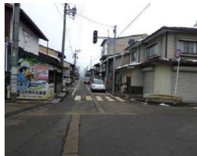
▲上金森町線（面的な側溝改良）
