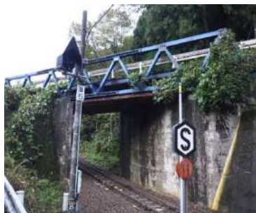
▲杉原～小豆沢線（JR跨線橋の架替）
