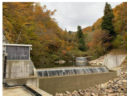
▲森安発電所取水えん堤(宮川水力開発)
