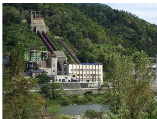
▲東町発電所(北陸電力)
