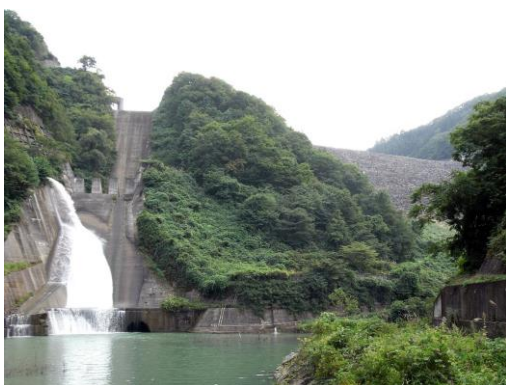
▲下小鳥ダム(関西電力)
