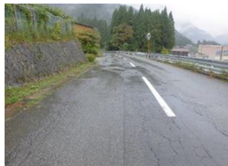
▲劣化した舗装の補修
