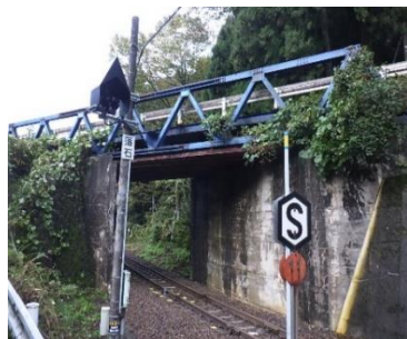
▲杉原～小豆沢線（JR跨線橋の架替）
