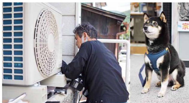
(左)エアコンの取り付け工事の様子、(右)カワデンの看板店長犬
