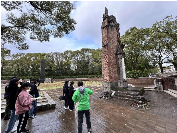
原爆により破壊され、わずかに残った旧浦上天主堂の堂壁。
