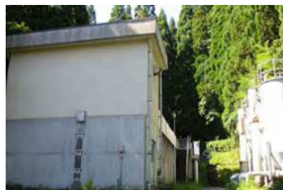
▲梨ヶ根浄水場
