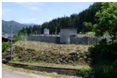
▲高野第1配水池
