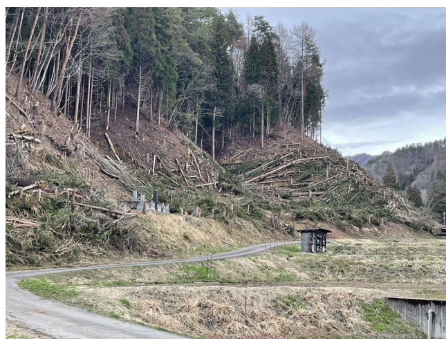
（写真 1）過去に実施した林縁部の立木伐採
