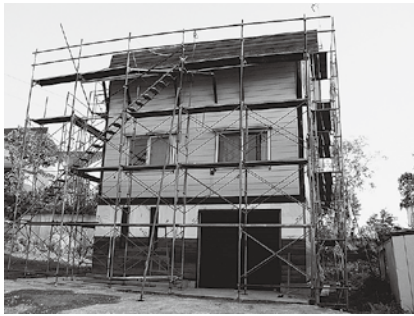
屋根・壁面を改修する住宅
