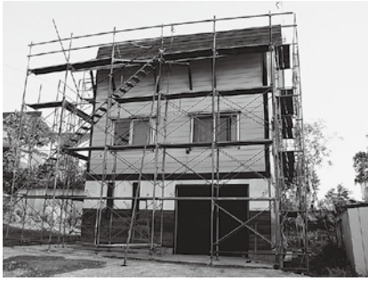
屋根・壁面を改修する住宅
