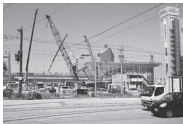
工事中の富山駅舎
