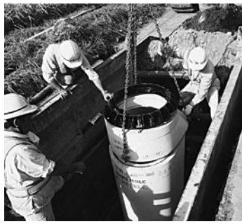
敷設される下水道マンホール
