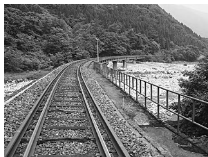
旧神岡鉄道 第一高原川橋
