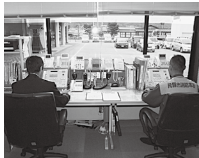
運用中の古川消防署指令操作卓
