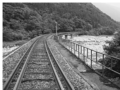
旧神岡鉄道 第一高原川橋
