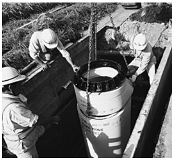
敷設される下水道マンホール
