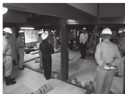
改修中の建物内
