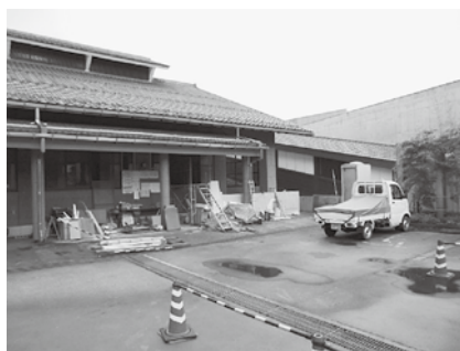
クリニックへの改装工事
