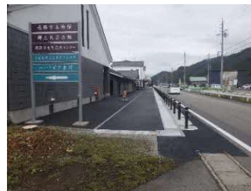
▲市道上気多・杉崎線（R6施工）
