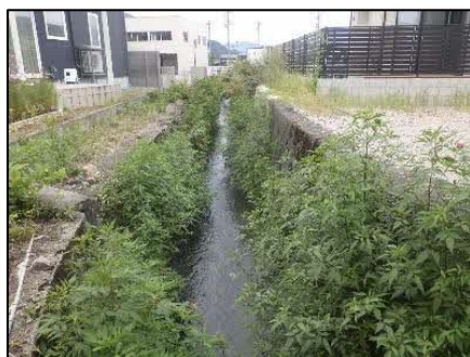
▲排水路（整備前）
