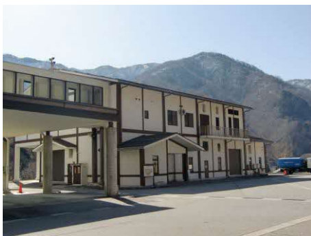
みずほクリーンセンター汚泥再生処理施設（宮川町）
