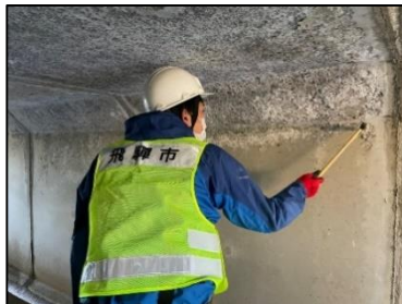
飛騨市職員による直営橋梁点検
