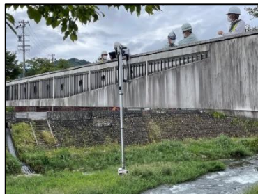
点検支援カメラによる点検 (飛騨市 吉城橋)
