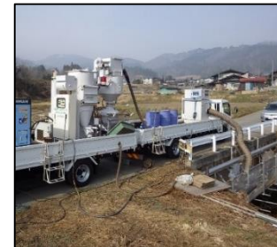
循環式エコクリーンブラストによる修繕 (飛騨市 683-1橋)
