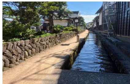
土舗装 (市道堀川町線)
