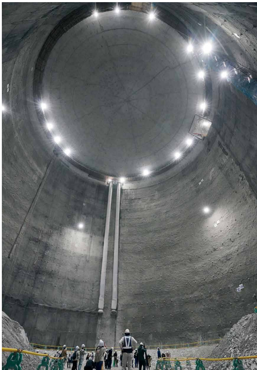
巨大水槽が設置される地下空洞の底部より
