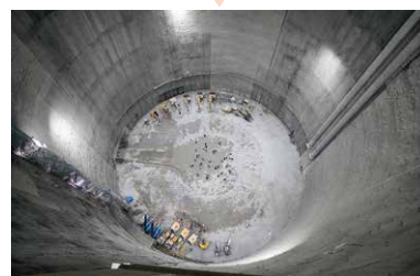
地下空洞・上部からの光景
