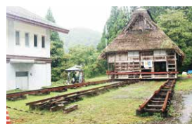
茅葺き古民家修復事業
