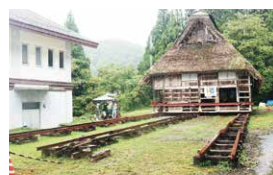
茅葺き古民家修復事業
