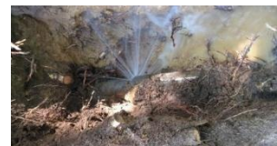
▲石神地内 石綿管漏水状況
