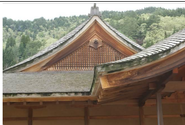
【A 類】復元会所西側屋根（屋根部の現状）
