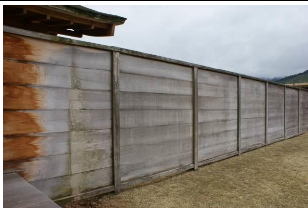
【A 類】復元構造物（板塀）
