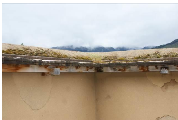
【A 類】復元土塀の修復箇所現状（南西端） …壁塗り修繕した箇所は色合いが若干異なる
