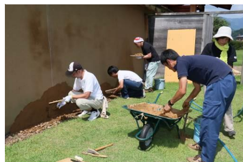
写真 4-18 土塀の壁塗り体験
