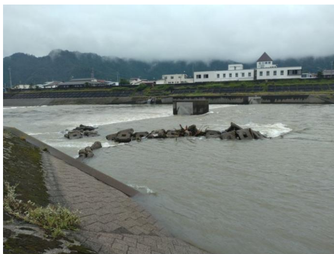
▲ (令和7年度被災状況) 大久古頭首工
