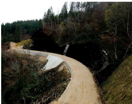
▲万波工区 (令和7年度施工箇所)
