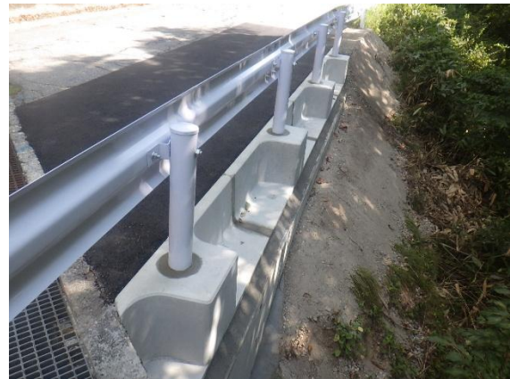
▲ガードレール補修
