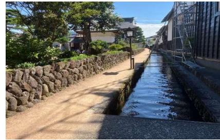
土舗装 (市道堀川町線)
