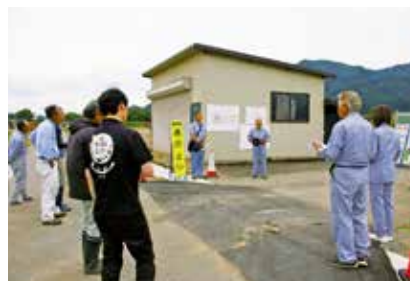
①土地改良（古川町杉崎）状況
