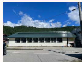
▲角川土間付体育館（河合地区）
