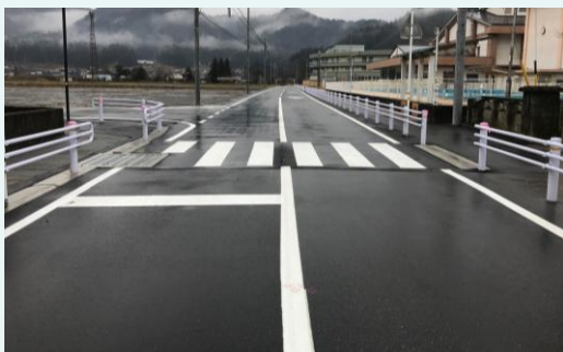
▲通学路緊急対策（歩道整備）
