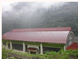
▲坂下体育館（宮川地区）
