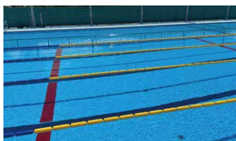
神岡小学校プールの改修
