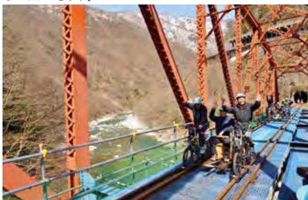
鉄橋を通過する住民ら
