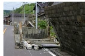
～参考：地震被害によるブロック塀の倒壊状況～
