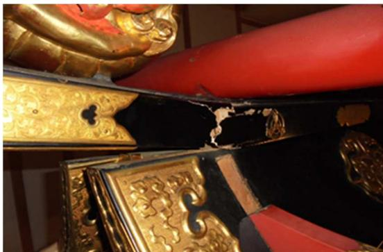
電線に接触し破損した祭屋台の屋根部
