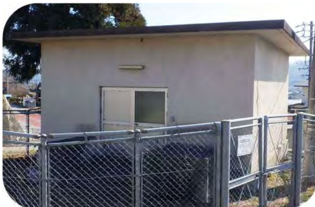
沢送水ポンプ場
