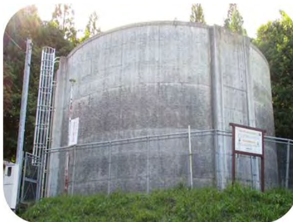
西高区配水池（PC造）
